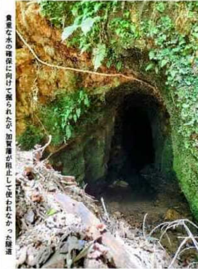
貴重な水の確保に向けて掘られたが、加賀藩が阻止して使われなかった隧道
