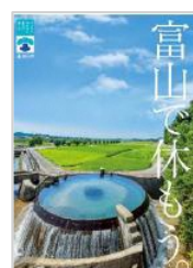
No. 20 東山円筒分水槽
