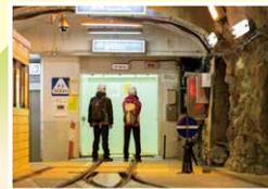
約200mの高低差を約2分で移動。貨車ごと運べるように、エレベーターの床にもレールが敷かれている。
